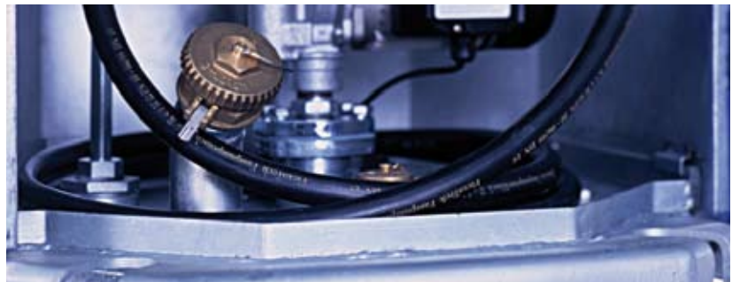
Domdeckel mit seitlichen Aufkantungen rundum (Diesel-Anlagen).
